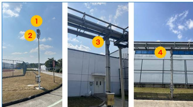
图 6. 英特尔成都工厂面向 AMR 的 5G 毫米波站点安装图
